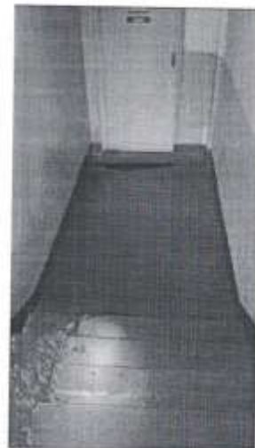
Фото 16. Дверь входная, лестница (запасной выход)
