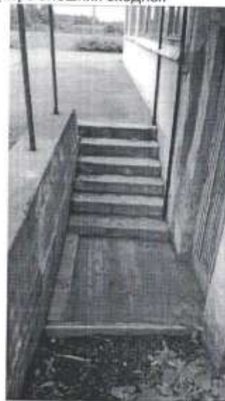
Фото 11. Лестница внешняя (запасной выход)
