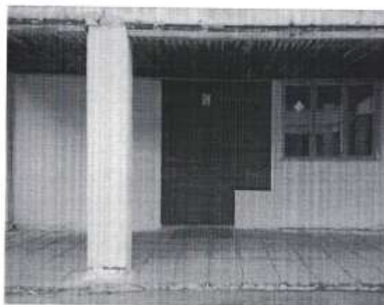
Фото 5. Входная площадка, дверь (центральный вход)
