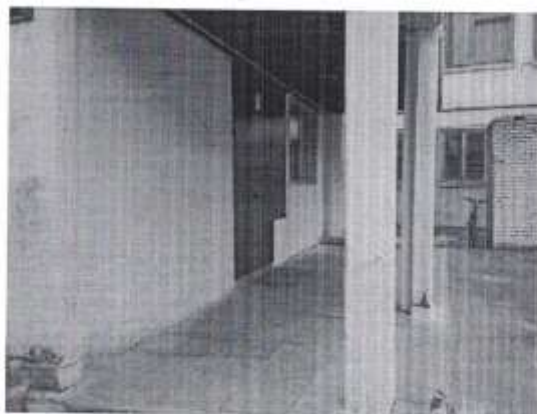
Фото 4. Входная площадка (перед центральной дверью)
