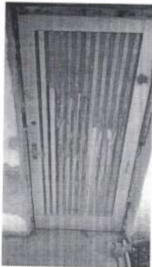
Фото 12. Дверь внешняя (запасной выход)
